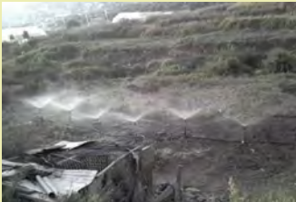
Foto 8: Sistema de riego por aspersión, instalado en sector de Ocoica, Mamiña.
