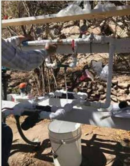
Foto 11. Centro Control sistema de riego. Operación de retrolavado por integrante de la comunidad.
