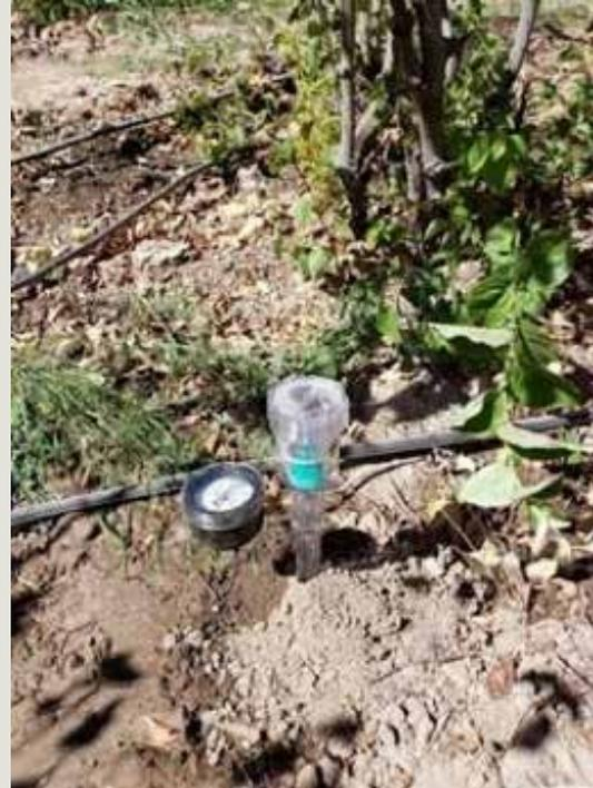
Foto 13. Sistema de inyección venturi instalado en el centro de control del sistema de riego.
