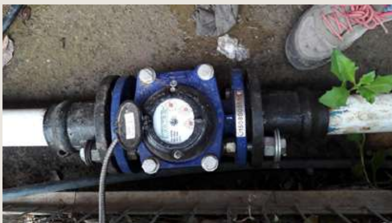
Foto 3: Contador de flujo (también llamado caudalímetro) para la cuantificación del volumen de agua utilizada para riego en predio de producción de frutales.
