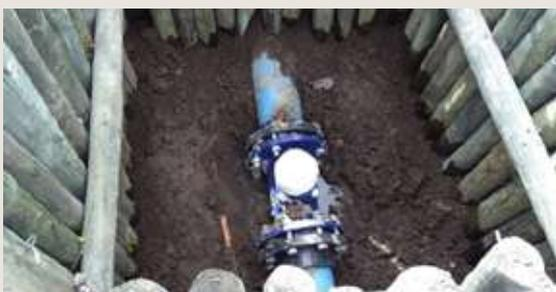
Foto 5: Contador volumétrico instalado en viña Super Fruit. Artefacto que permitirá determinar el consumo de agua utilizada en riego, permitiendo así determinar huella azul.
